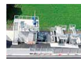
▲安永雨水ポンプ場
