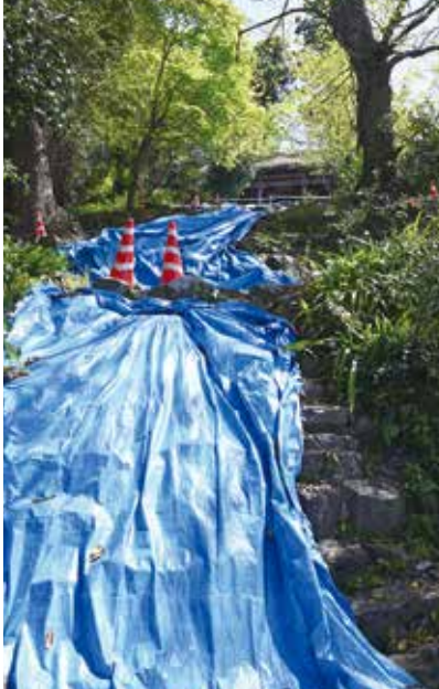
改修工事が進んでいる「乱れ積法」の石段
