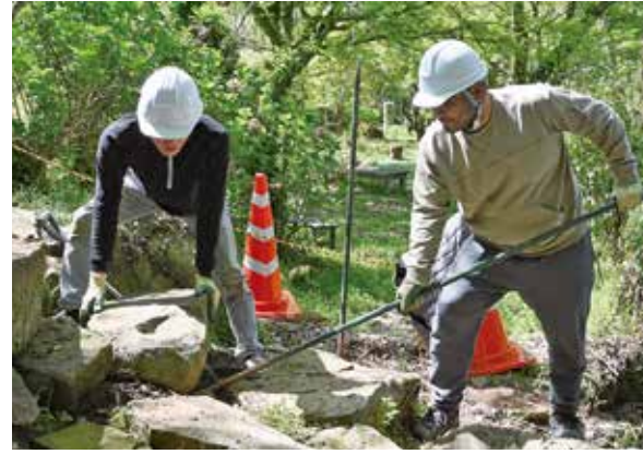
常楽寺の石段の積み直しの作業が行われていました
