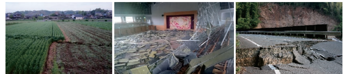
露出したクラック断層 総合体育館メインアリーナ 地盤沈下した道路
