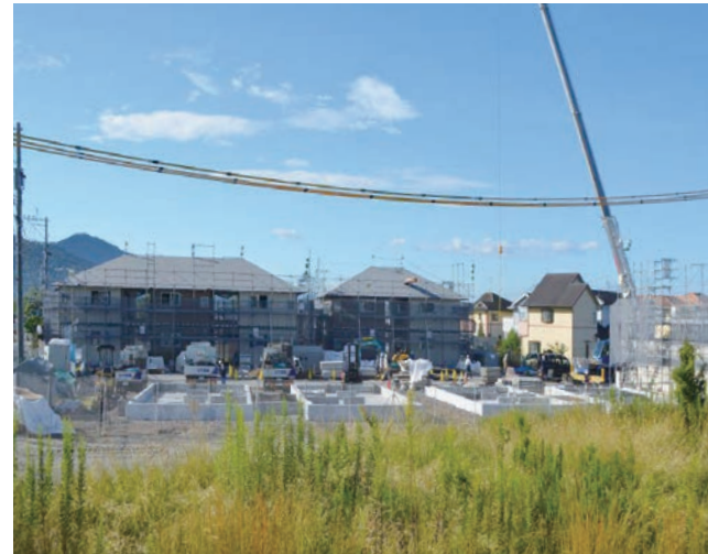
建築中の災害公営住宅（宮園地区）
