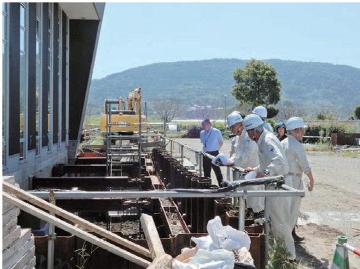
交流情報センター災害復旧工事現場
