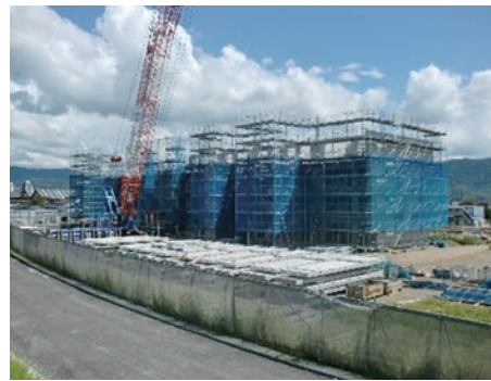
来年4月建設予定の災害公営住宅
