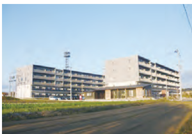
町営住宅馬水団地
