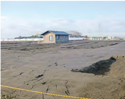
農地へ復旧される馬水仮設団地
