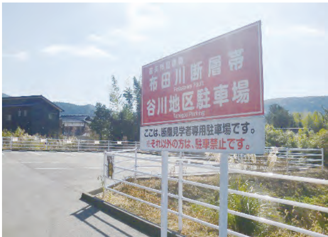
バリカー設置工事が行われる谷川地区駐車場
