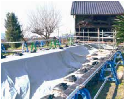
保護シートで覆われた谷川地区
