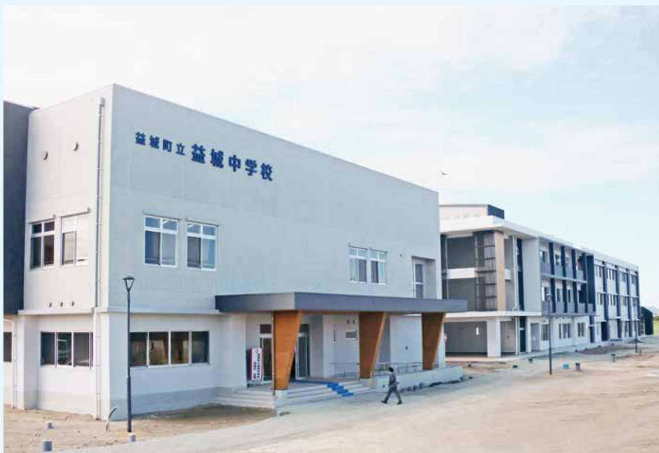
再建された益城中学校校舎及び体育館
