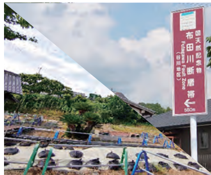
進めめ現地状況(下)に対し進む案内看板(上)等
