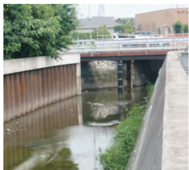
妙見川県道熊本高森線仮橋梁
