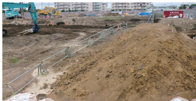
本庁舎工事で発生した土砂
