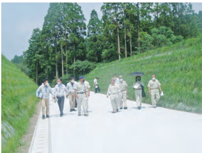
完成した潮井農道（杉堂地区）
