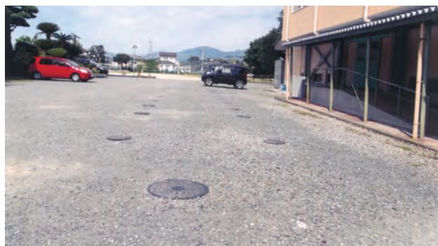
広安小学校のマンホールトイレ
