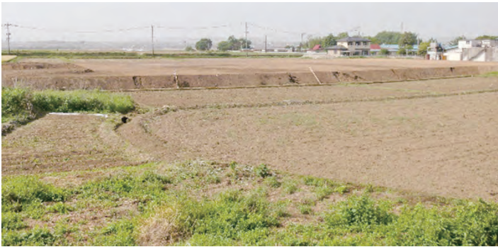
工事発生土を運搬処分した小池地区の現場
