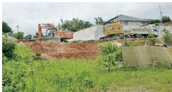
益城中央市街地区画整理事業内の建設現場
