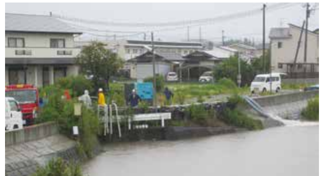
安永中井出地区の排水作業
