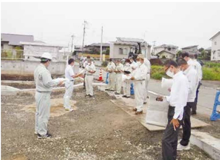
益城東西線工事現場（辻ノ城地区）
