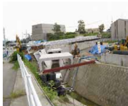
寺迫交差点復興工事状況
