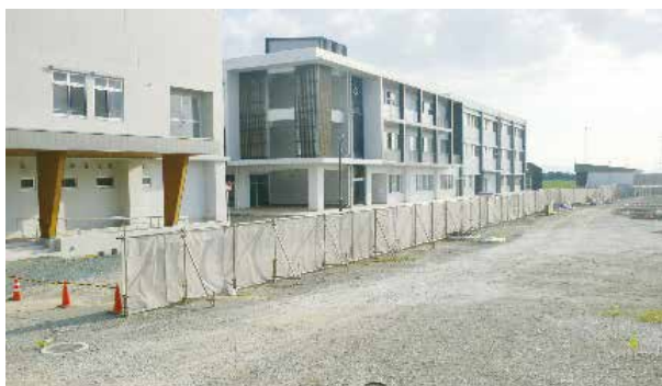
益城中外構工事予定地
