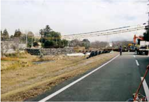
秋津川木山橋橋梁工事
