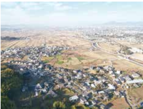
木山川で一線を画す市街地と集落部
