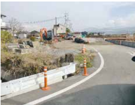
安永雨水ポンプ場工事の状況
