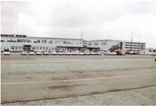
複合施設建設予定の現益城仮庁舎用地
