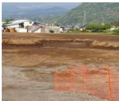
小池地区の土砂受入地
