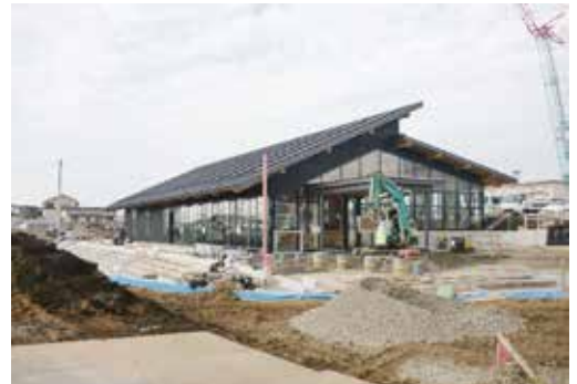
建設中の復興まちづくりセンター
