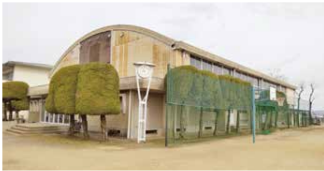
空調設備の整備が望まれる学校体育館
