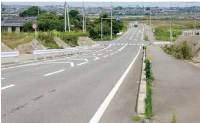
防犯灯を整備する県道小池竜田線
