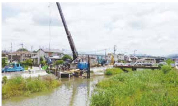
安永排水ポンプ工事現場
