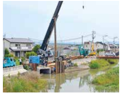
工事中の安永排水ポンプ場
