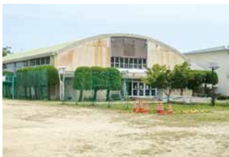
改修工事予定の飯野小学校体育館
