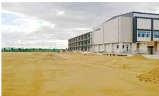
整備中の益城中学校運動場
