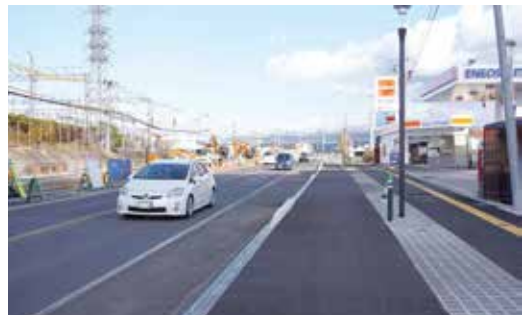
令和5年春に供用開始予定の広崎区間
