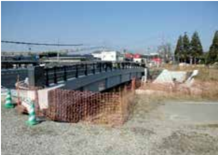
横町線木山橋改修工事現場
