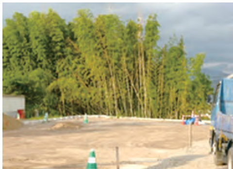
工事中の寺迫地区避難広場
