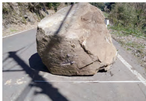
通行の妨げとなっている落石（川内田地区）
