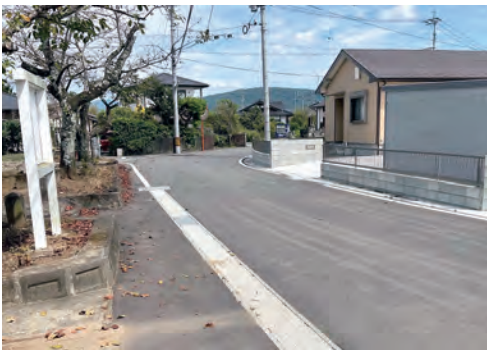
まちづくり協議会の提案により拡張された道路(櫛島)
