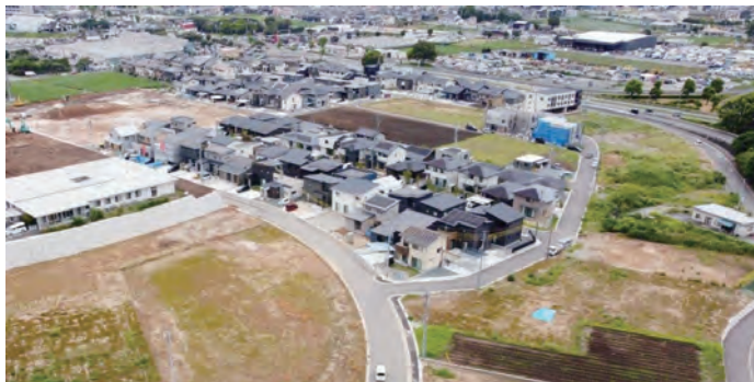
広崎地区(益城熊本 IC 西側)の宅地造成地域
