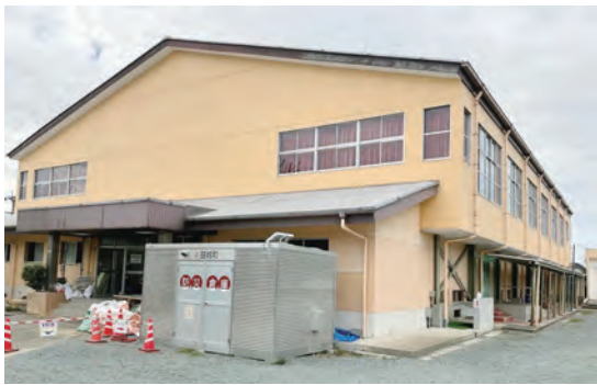
開設された避難所の広安小学校体育館
