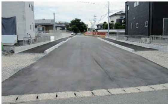
工事が進む第2 南北線(馬水地内)
