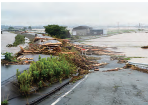
木山川が氾濫し水田に流入した流木や川砂
