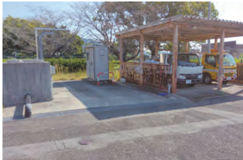
刈払機で車に損傷を与えた水道センター現場
