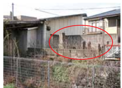
現在では墓地のみが残る東福寺跡 (文化会館敷地内北側から)
