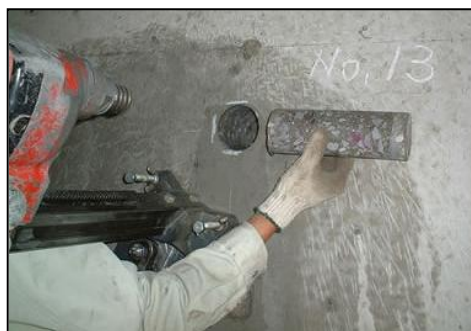
詳細点検（コア抜き調査）
