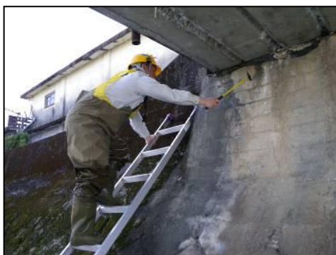
定期点検（打音検査）
