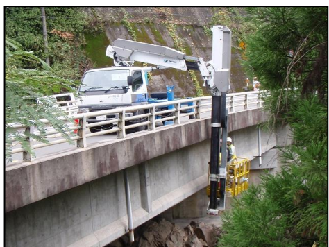
詳細点検（橋梁点検者による）近接目視点検
