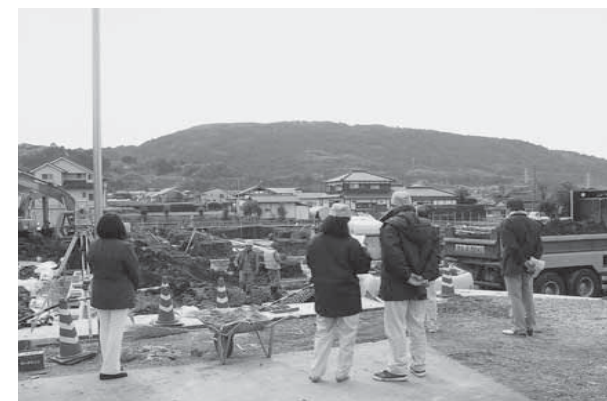
いこいの里（仮称）建設現場
