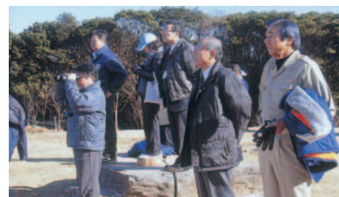
飯田山公園整備工事現場
