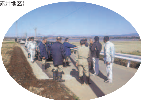
町道小池一本杉線側溝整備現場視察
