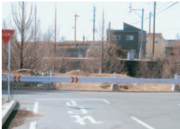
正面が鉄砂川橋工事現場
