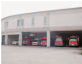
高遊原南消防本部
