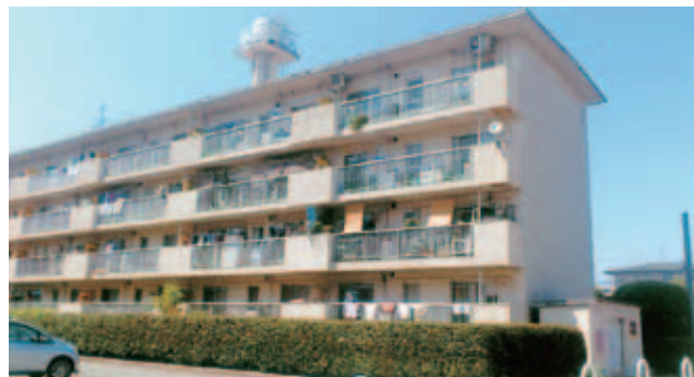
国の補正予算を活用して外壁改修予定の市ノ後団地
