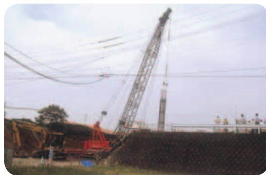
グランメッセ木山線跨道橋下部工築造打杭工事
