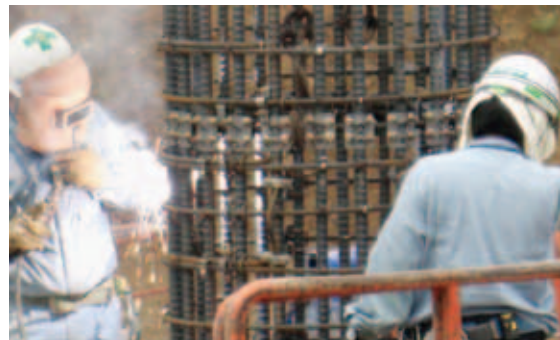
地域再生道路橋りょう工事現場
