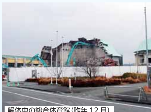
解体中の総合体育館 (昨年12月)
