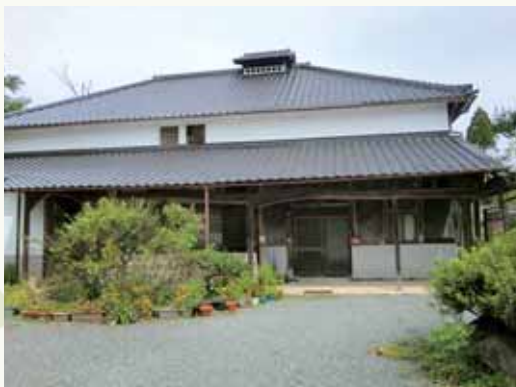
解体前の西園寺家住宅
