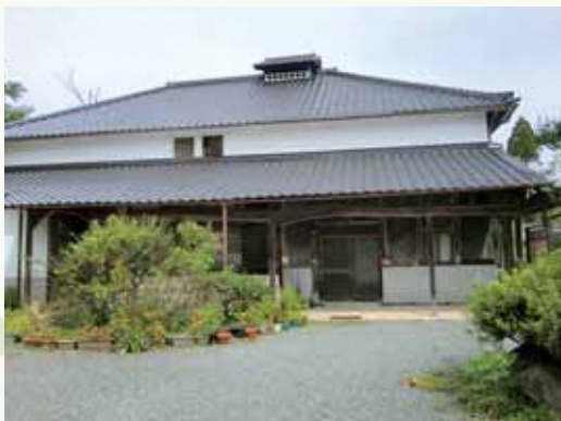
解体前の西園寺家住宅
