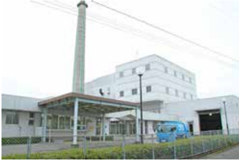
益城クリーンセンター
