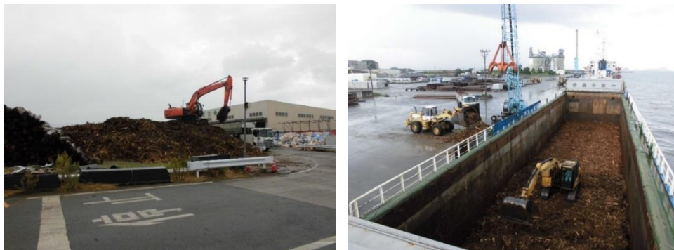
(株) 津田での中間処理及び船便輸送風景（平成 29 年 9 月 7 日撮影）
