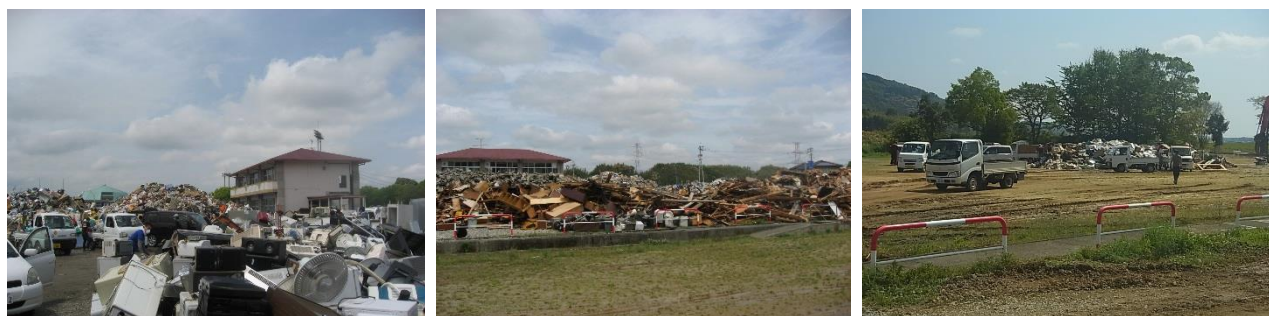
4/22の仮置場状況（左：東側からの全景 中：南側からの全景 右：使用し始めた南側用地）
