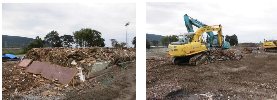
台風対策の例（平成29年9月台風18号接近時）
