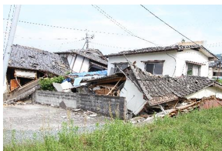
敷地内建物全てが倒壊したもの
