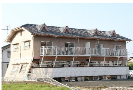
1階部分が傾斜した共同住宅
