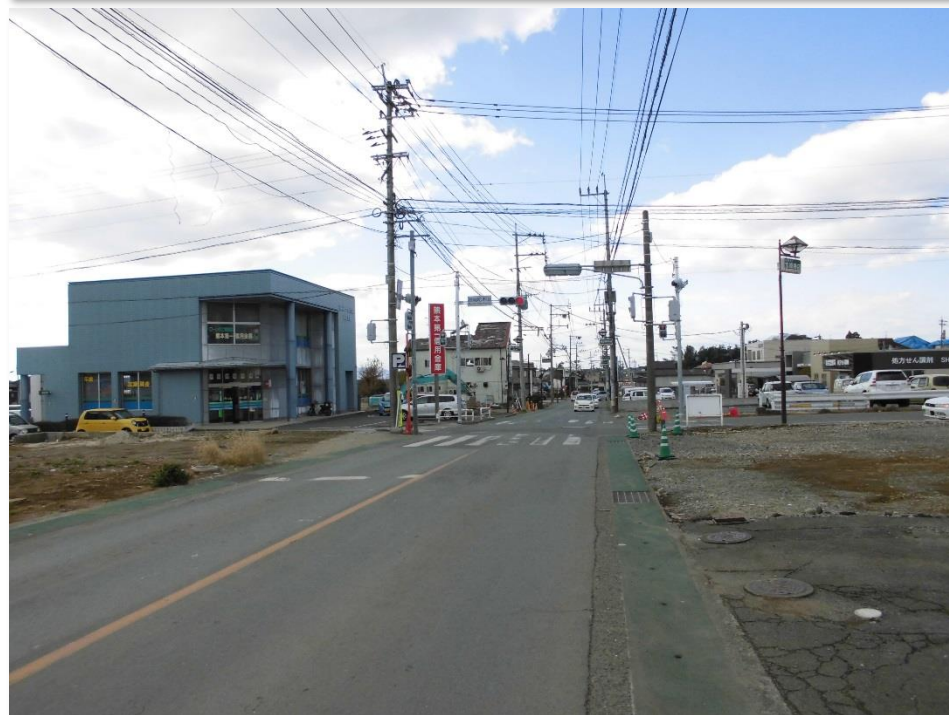
○損壊家屋等の解体撤去が進む木山交差点付近
