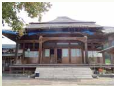
修復中の本堂
