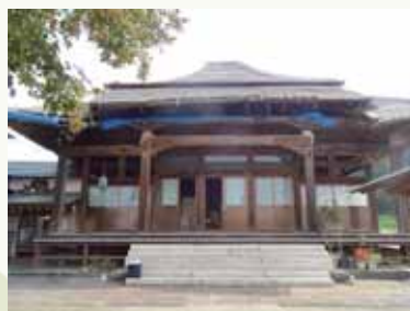
修復中の本堂
