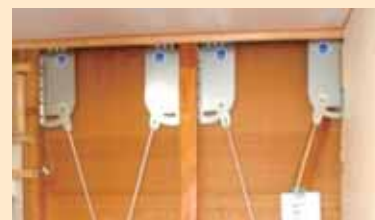
筋交いによる補強の例
