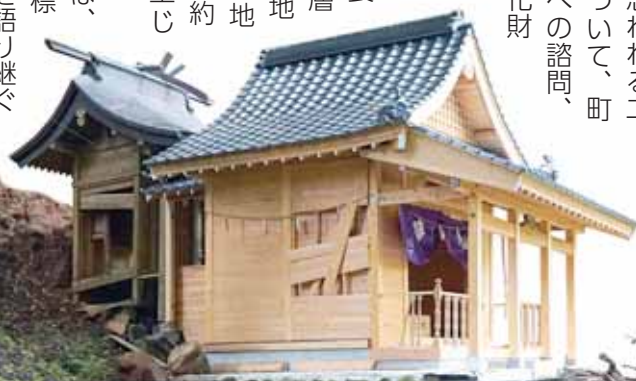
▼町文化財に指定された、塩井神社境内の地表に現れた活断層
