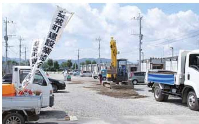
厳しい日射しの中、作業を行う町建設業協会
