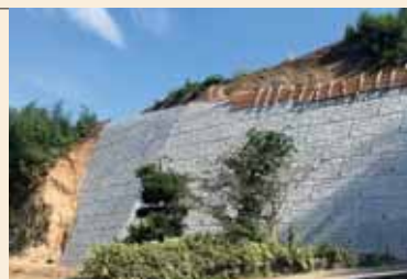
杉堂地区で行われている復旧工事
