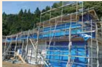
潮井自然公園内に建設中の四賢婦人記念館
