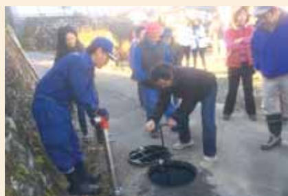
消火栓の開栓・閉栓の方法を学ぶ参加者たち
