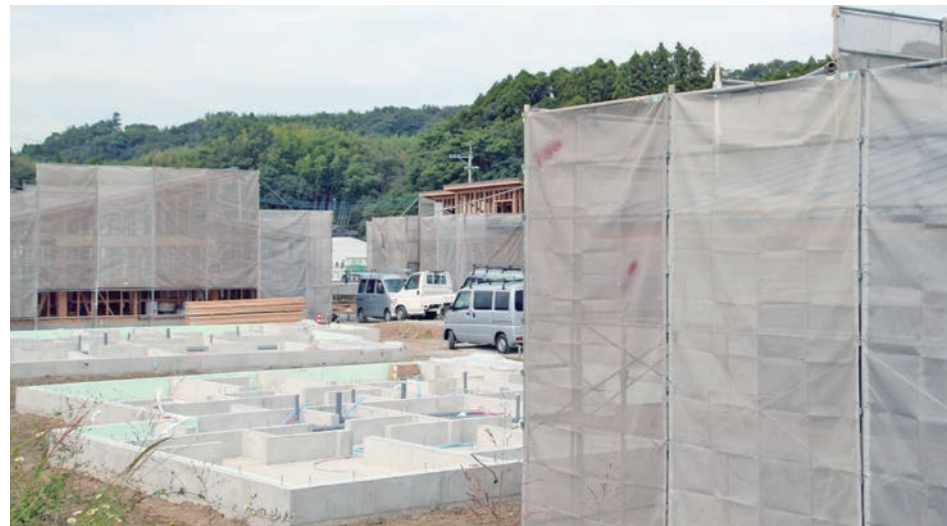
進み始めた災害公営住宅建設（田原地区）
