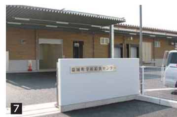
1 2 3ほかほかの給食です 4大きな釜で給食を作りますが見学できます 5感謝状を受け取る澤田さん 6テープカットのようす 7新しい給食センターの外観
