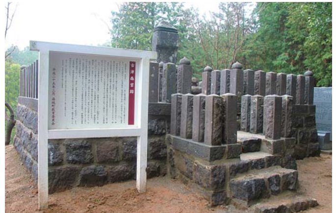
復旧工事が完了した影向石
