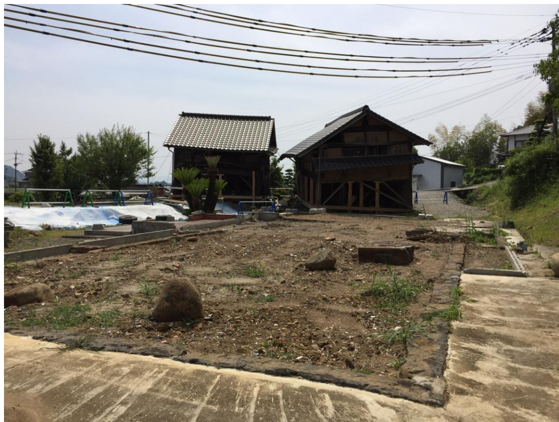
母屋の解体と仮保存による納屋支柱施工(谷川地区)
