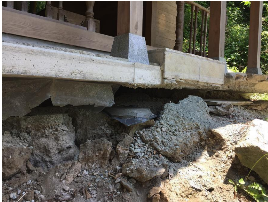
仮保存施工前(杉堂地区)
