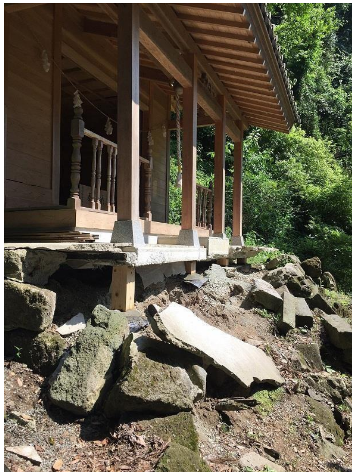
仮保存による支柱施工(杉堂地区)
