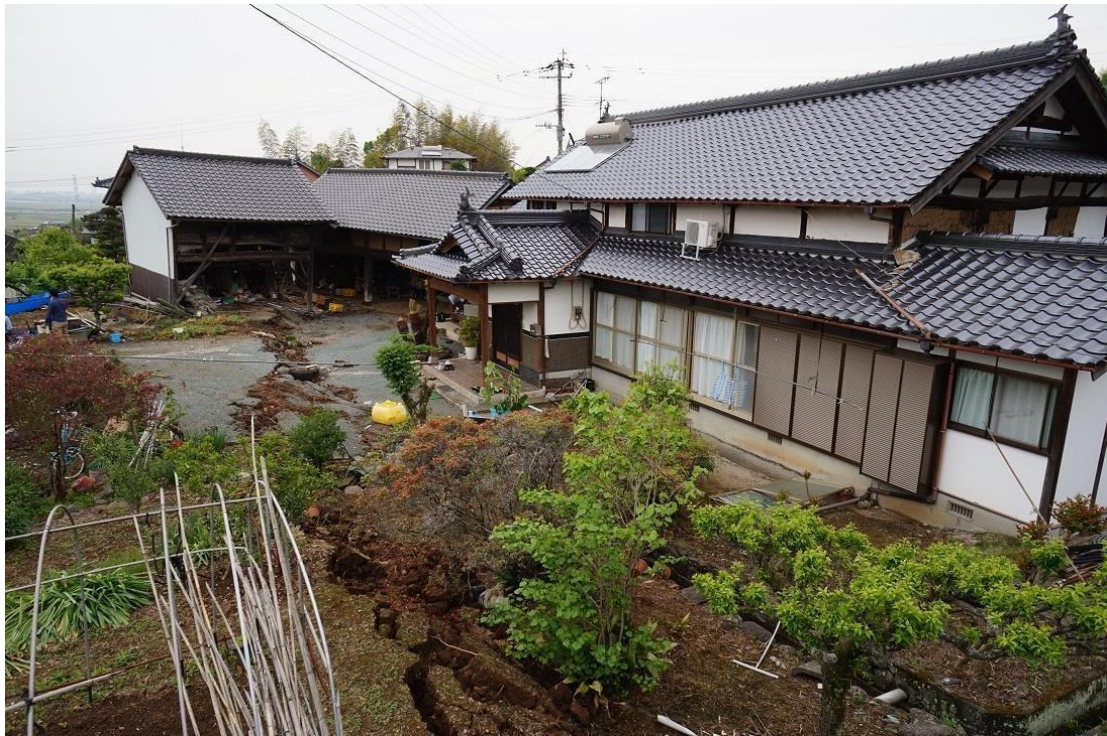
仮保存・解体施工前(谷川地区)
