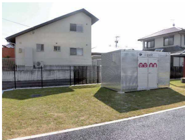
防災設備倉庫
