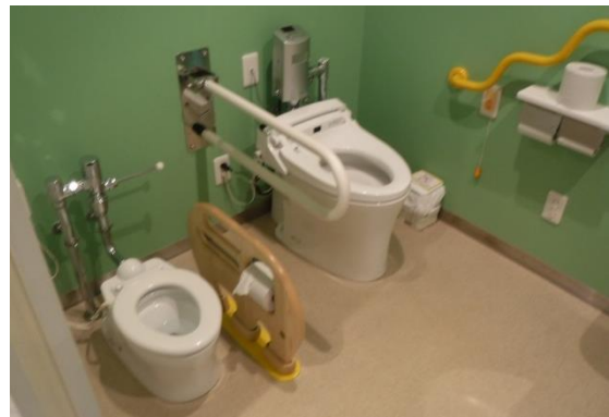
トイレの例（幼児用トイレ併設）
