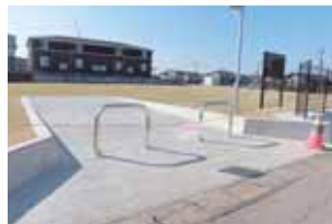
完成した辻団地地区避難広場
