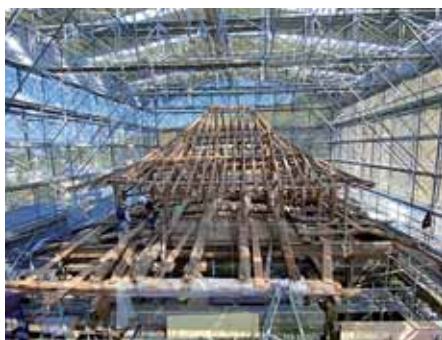
素屋根を掛けて行っている解体工事
