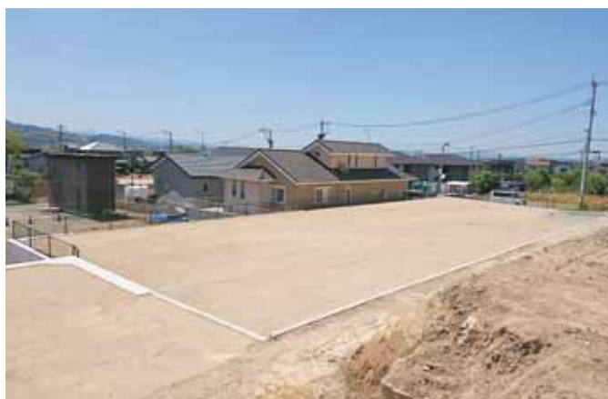
造成工事が完了した5画地の中の1画地
