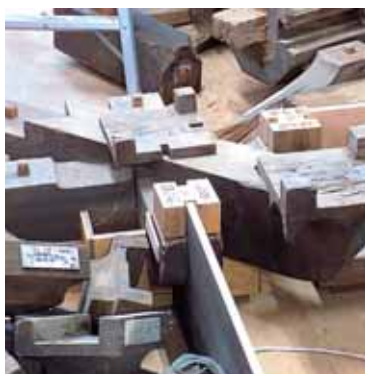
補修作業中の部材
