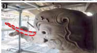
1 素屋根の中での工事 2 赤色の点線で囲んだ修復部分は、周囲の色に合わせて塗装される 3 象鼻の修復部分 4 はりの修復部分
