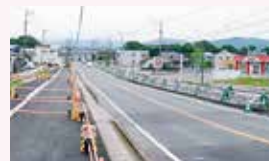
着々と進む4車線化事業 （写真はモデル区間）
