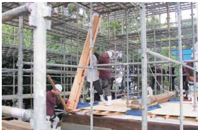
宮大工の手で立てられる今年作られた柱。右に見えるのが神殿から取り出した柱
