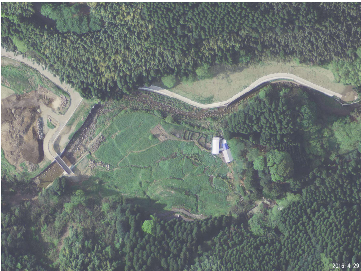
図 3-2 布田川断層帯(杉堂地区)の航空写真
