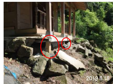
コンクリート打設、支柱設置
