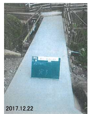
復旧後の通路・階段
