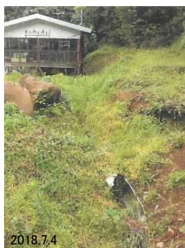
復旧前の水路
