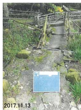
復旧前の通路・階段
