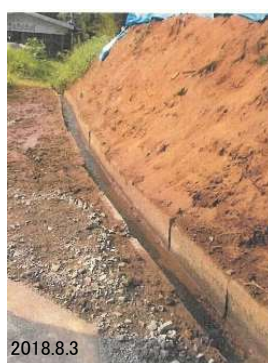
復旧後の水路
